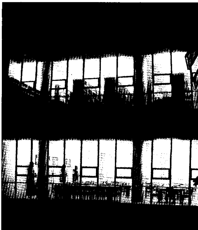
Fig. 11. El almacén de libros (5° piso) y el salón de lectura (1° piso) de la Hemerobiblioteca del Departamento de Fisiología, vistos de noche, desde fuera, por su lado Norte.
