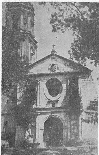
Fig. 9. Iglesia del Hospital de Santa Fe, estado actual.
