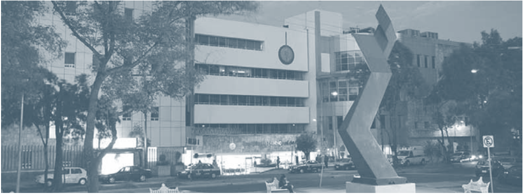
Figura 13.4. Vista de frente del edificio actual del Instituto Nacional de Cancerología (INCAN o INCancerología).
